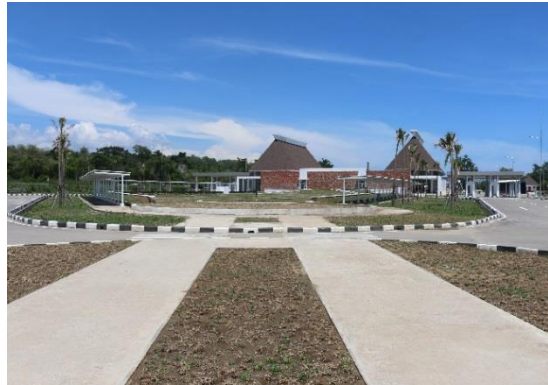
PEKERJAAN PEDESTRIAN DAN LANSEKAP
