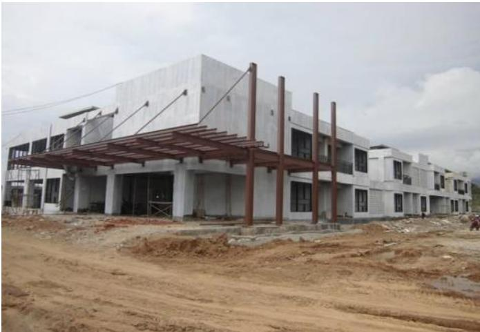
**Pemasangan Atap Baja dan Pengecatan Dinding Mess Pegawai**
