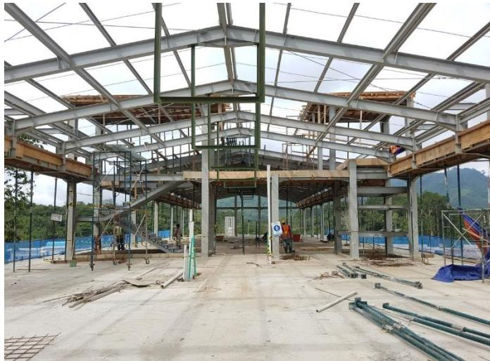
Pemasangan Bekisting Dak Wisma Indonesia
