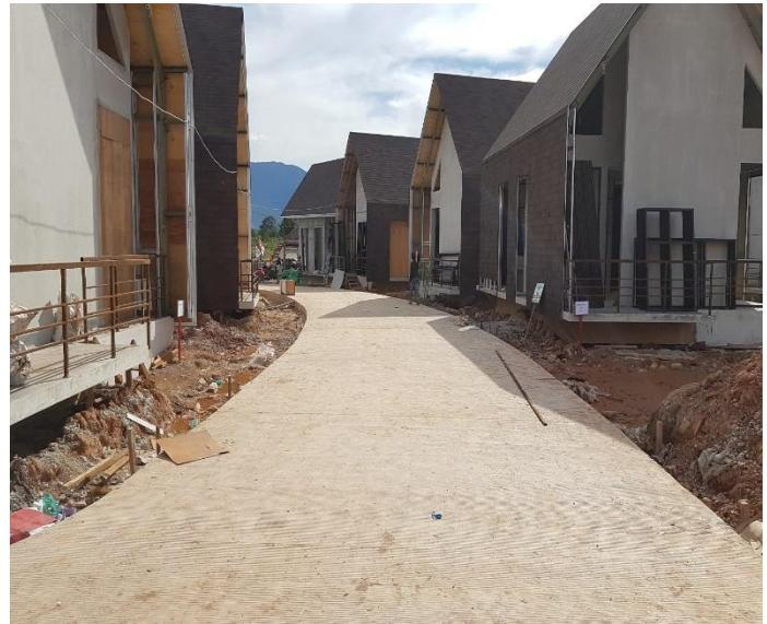
Pekerjaan Pengecoran Rigid Jalan Ruas 1
