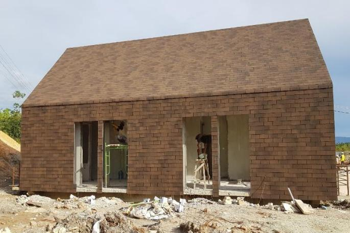
Pemasangan Bitumen Pada Dinding Rumah Tipe 75
