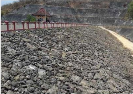
Waduk Jatigede digenangi 08/2015 – 50 tahun mangkrak
