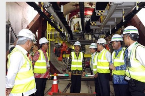
LRT Groundbreaking 9/9/2015 setelah mangkrak sejak Okt 2013
