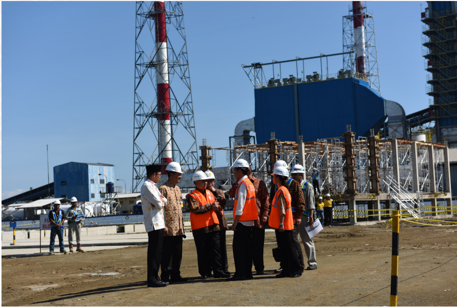
Presiden Jokowi pada groundbreaking Mobile Power Plant (MPP) Jeranjang, di Lombok Barat, Nusa Tenggara Barat, tanggal 11 Juni 2016
