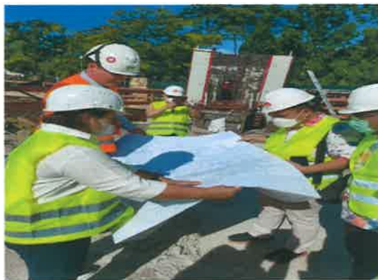
Gambar 3.4 Peninjauan Lokasi Pembangunan Gedung KBRI Berlin
